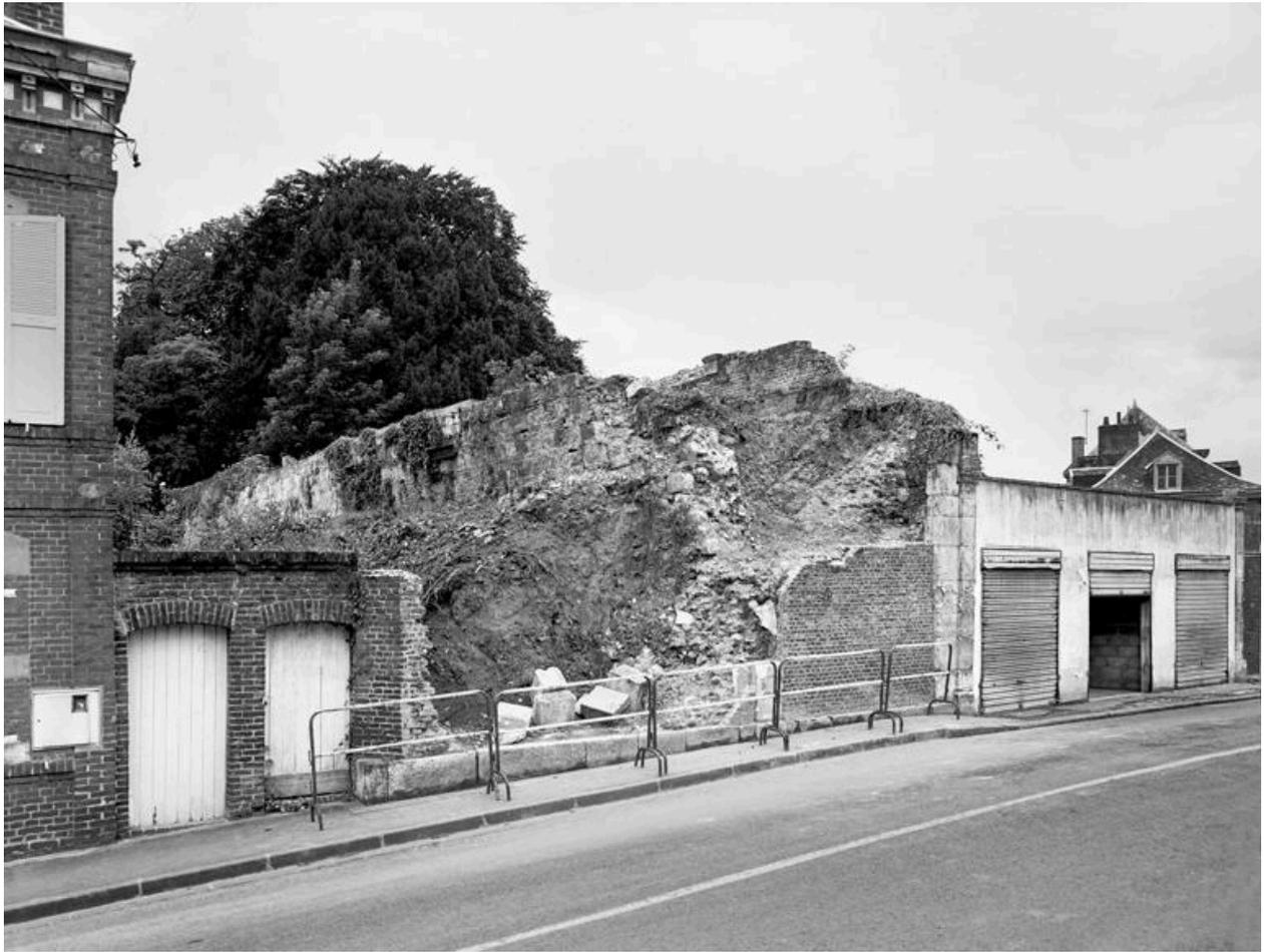
Vue réalisée en 1998, depuis la rue Condorcet, mettant en évidence la composition faite de 2 parements de grès et d'un remplissage de blocailles noyées dans un mortier.
