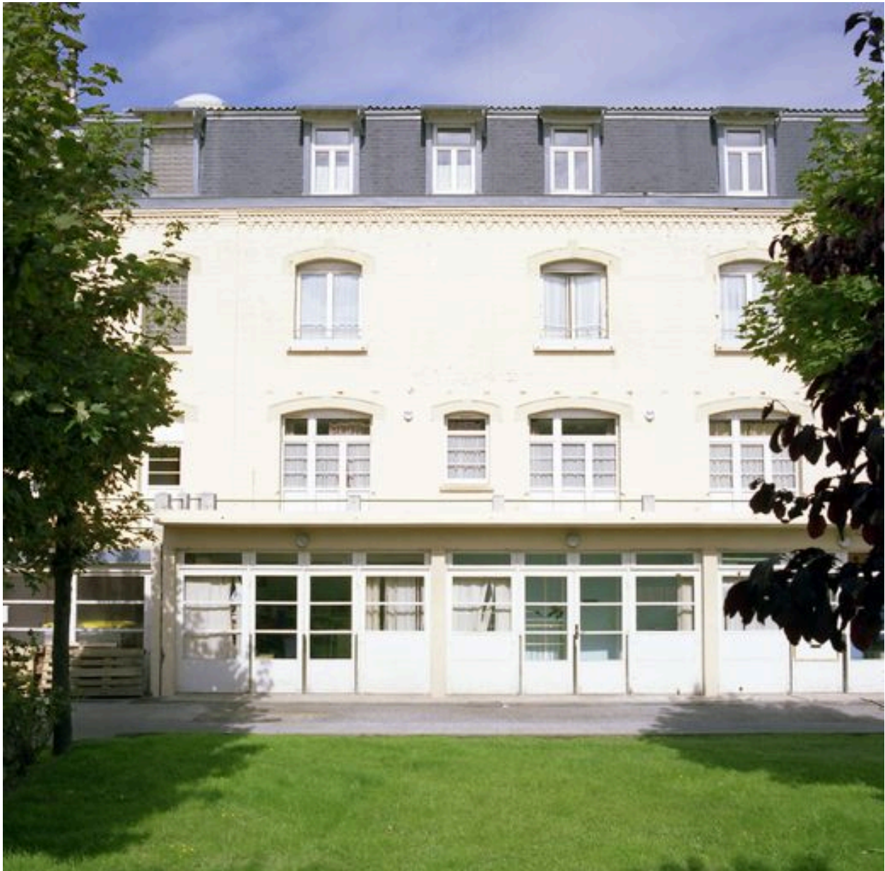
Corps de logis donnant sur la rue de Lhomel, élévation postérieure.
