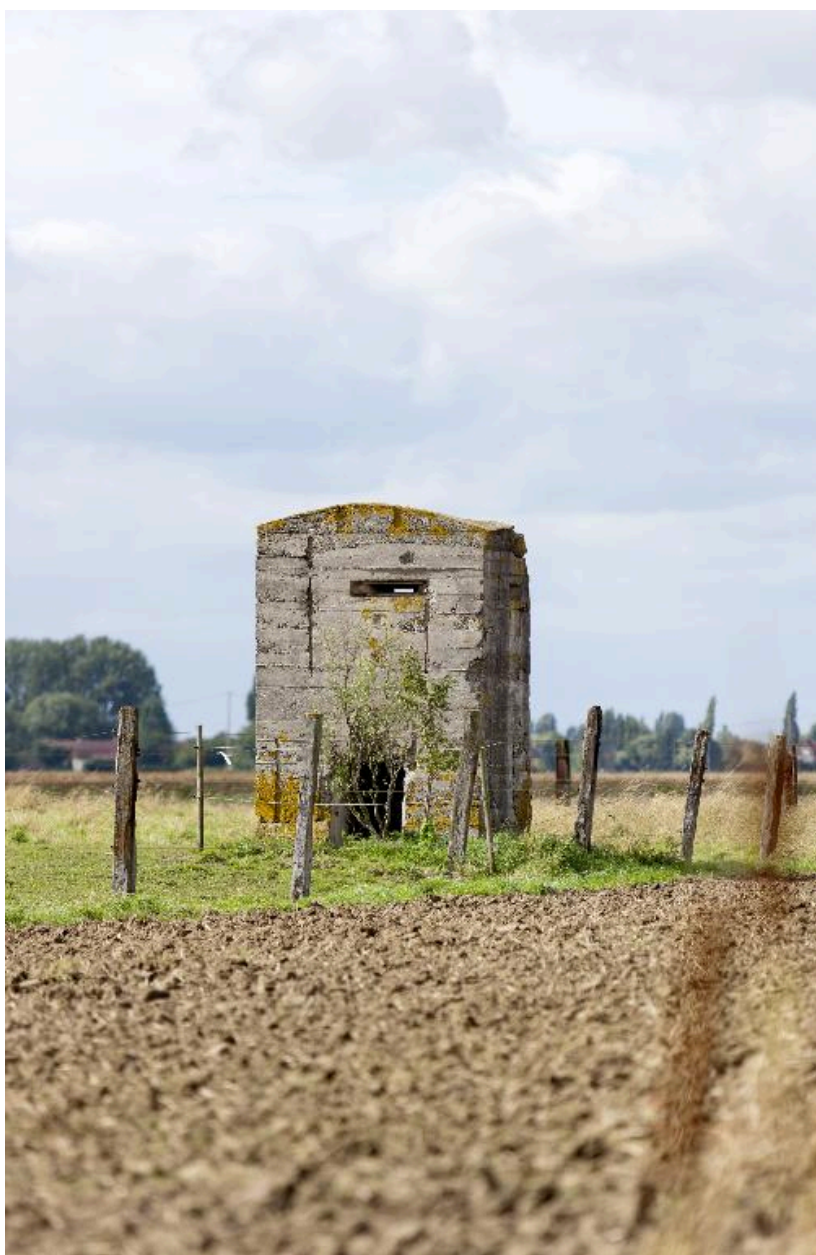
Vue générale vers le nord-ouest
