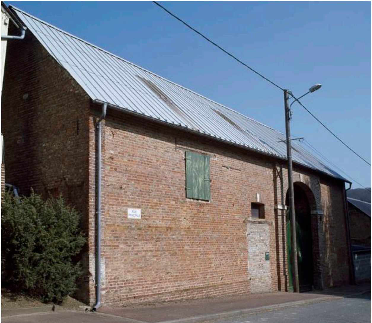
Vue de la grange depuis la rue.
