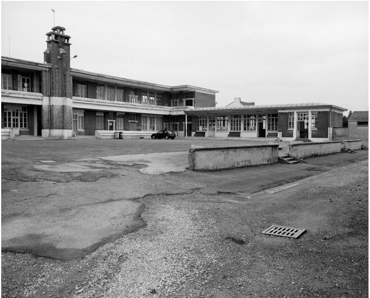
Élévation postérieure partielle et la cour.
