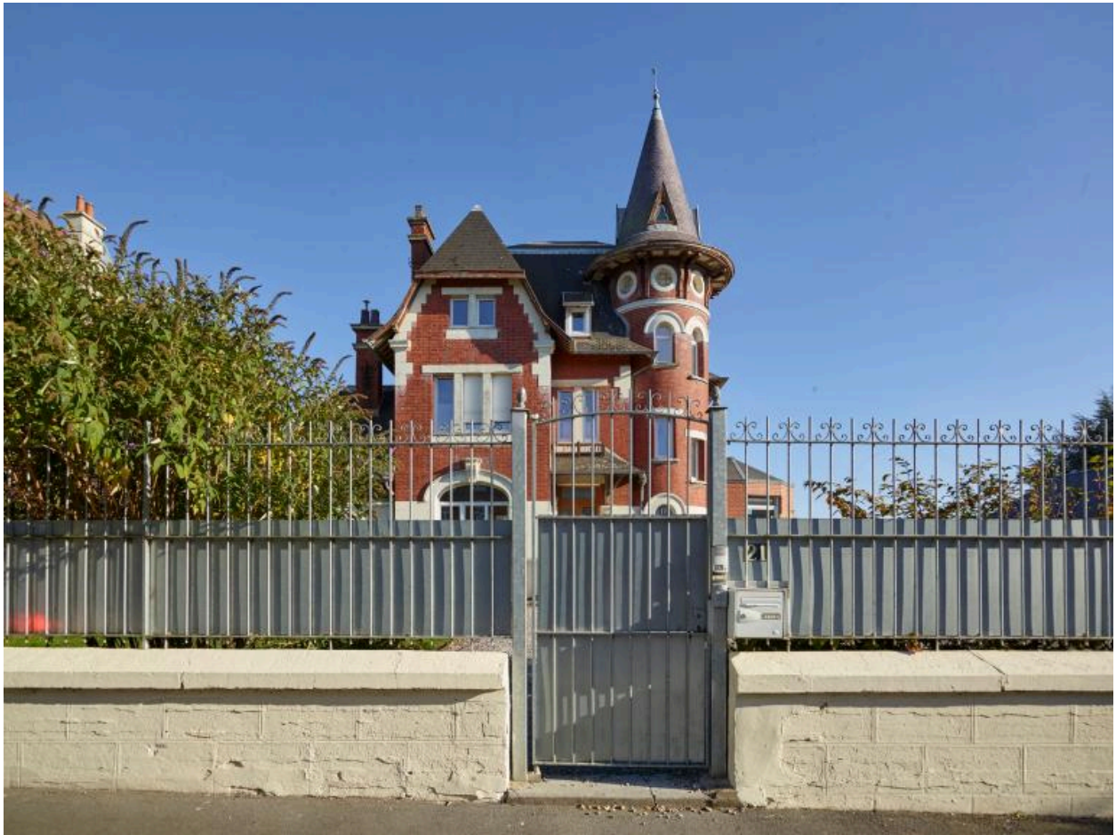
Vue depuis la rue de la République.
