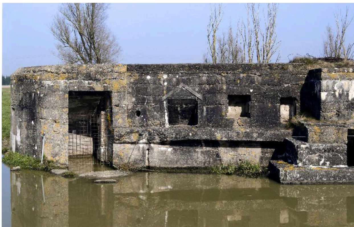
Elévation sud, entrée ouest, banquette de tir et niches à munitions
