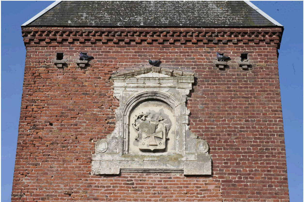
Tour porche (côté cour interne). Détail du cartouche architecturé et des boulins de pigeons.
