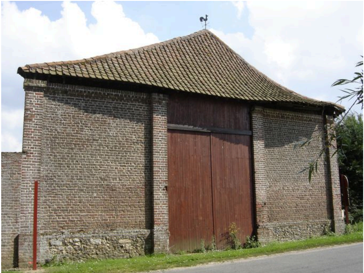
Vue latérale de la grange depuis la rue.
