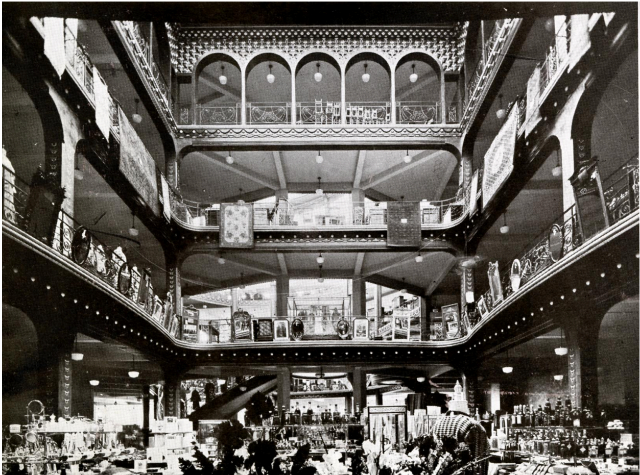
Vue de l'atrium rectangulaire entre 1927 et 1934 (Cité de l'Architecture et du Patrimoine ; fonds des Bétons armés Hennebique ; 3-D-364-e).
