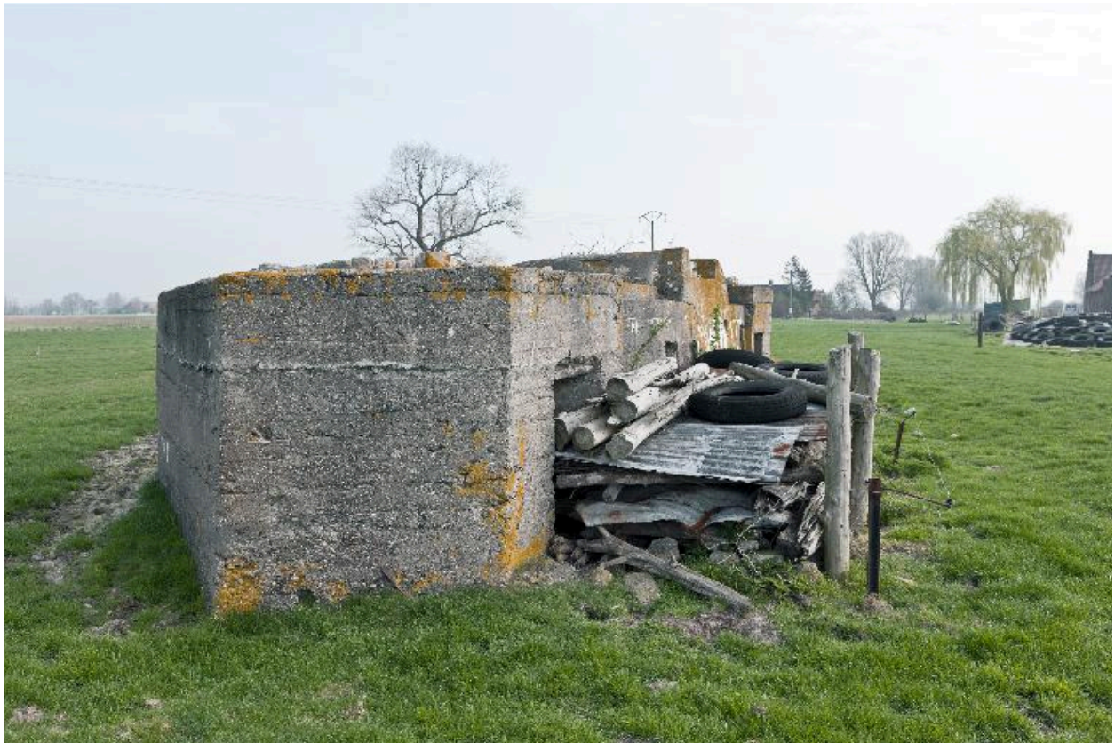
Vue de trois-quarts, vers le nord-est
