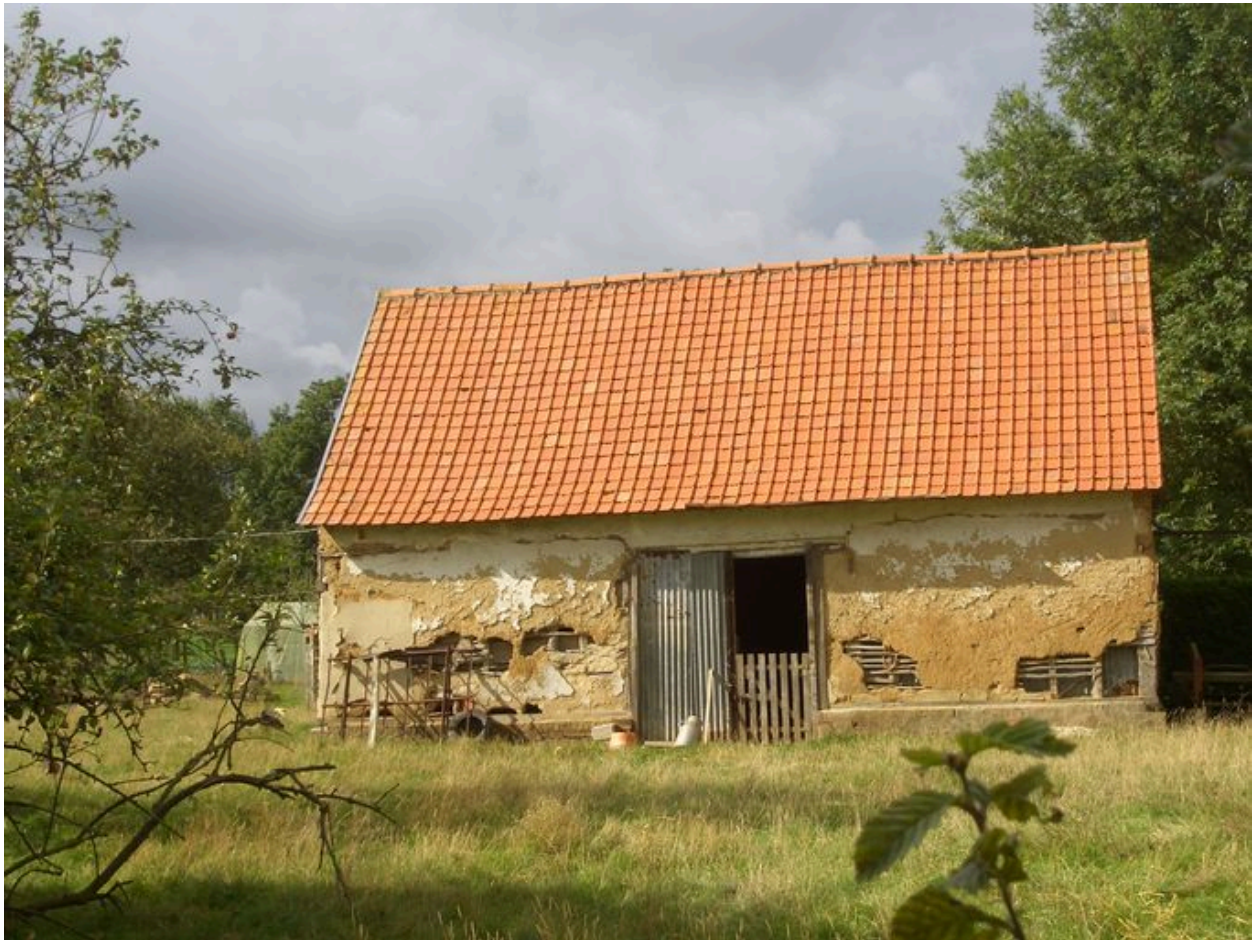
Vue de la grange.
