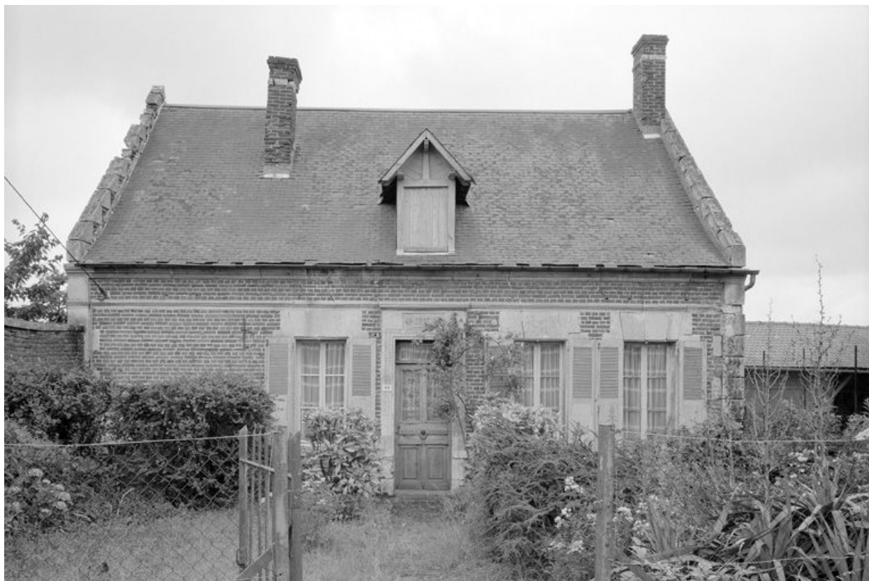
Logis. Elévation antérieure.
