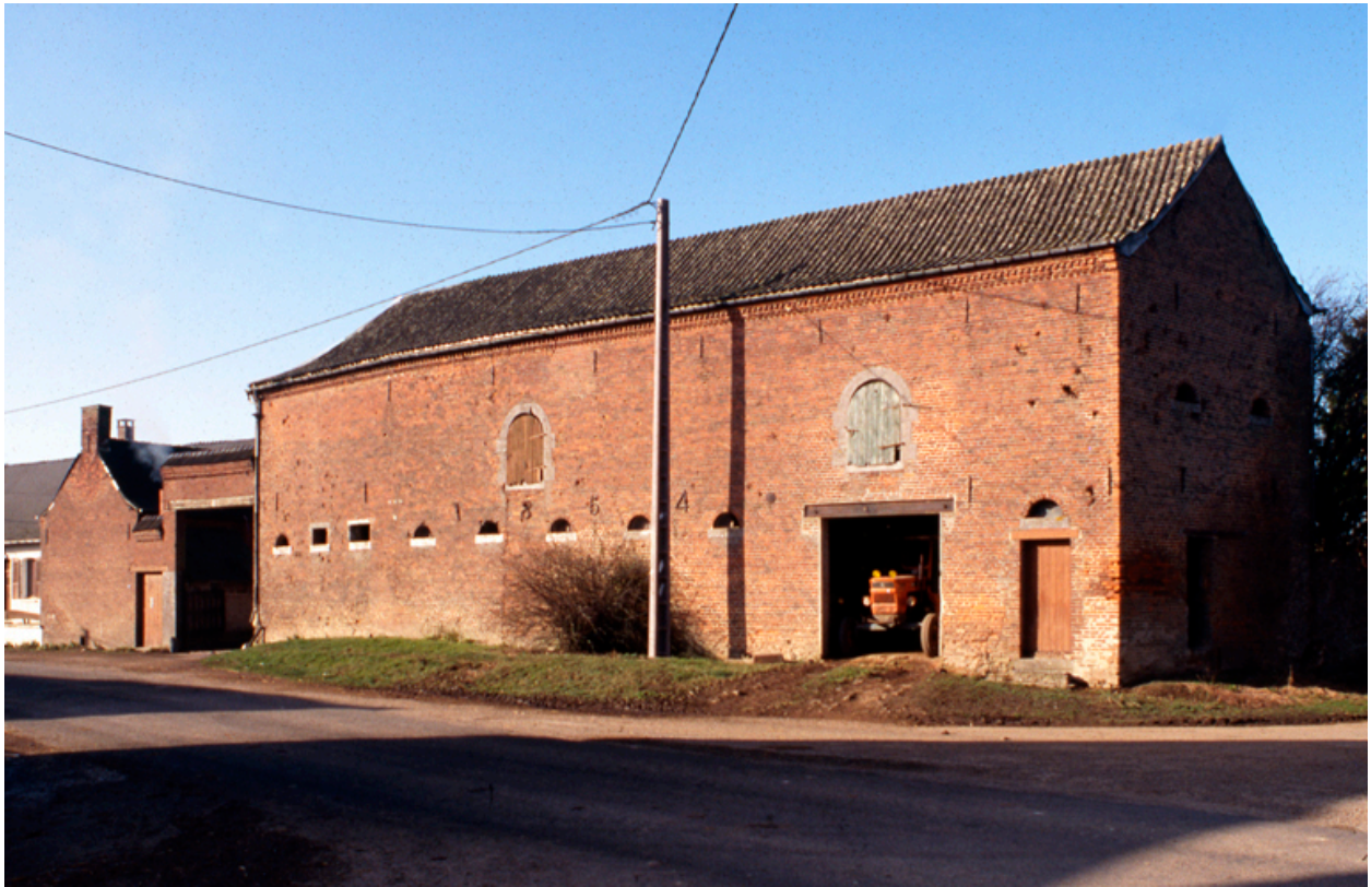
Vue d'ensemble de l'élévation sur rue, depuis le nord-est.
