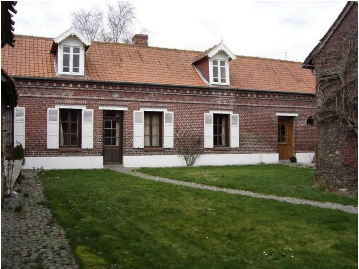
Vue du logis depuis la rue.
