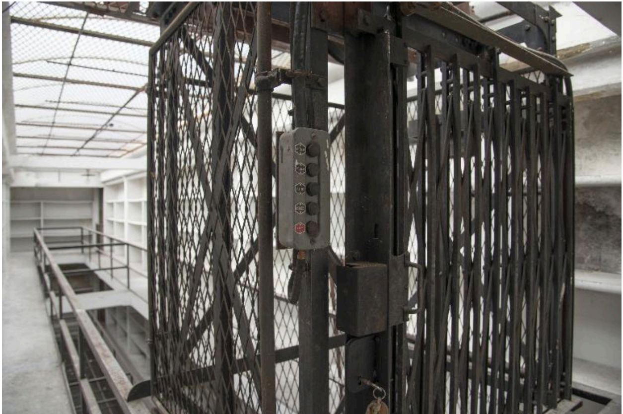
Bâtiment du dépôt, troisième étage : détail du monte-charge, vaisseau 1.
