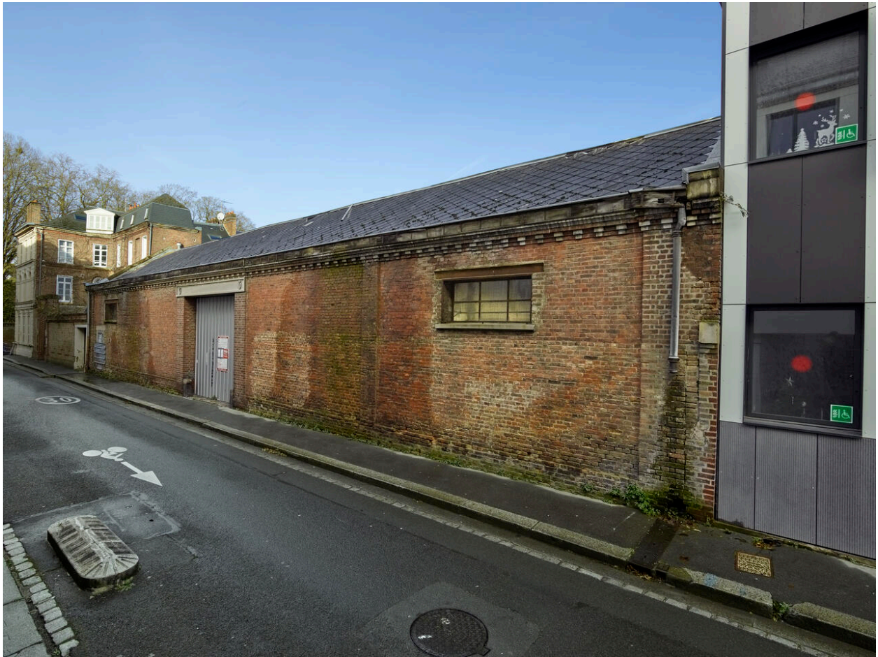
Vue générale de l'entrepôt rue Duthoit (en fond de parcelle). Vue prise depuis le sud-est.
