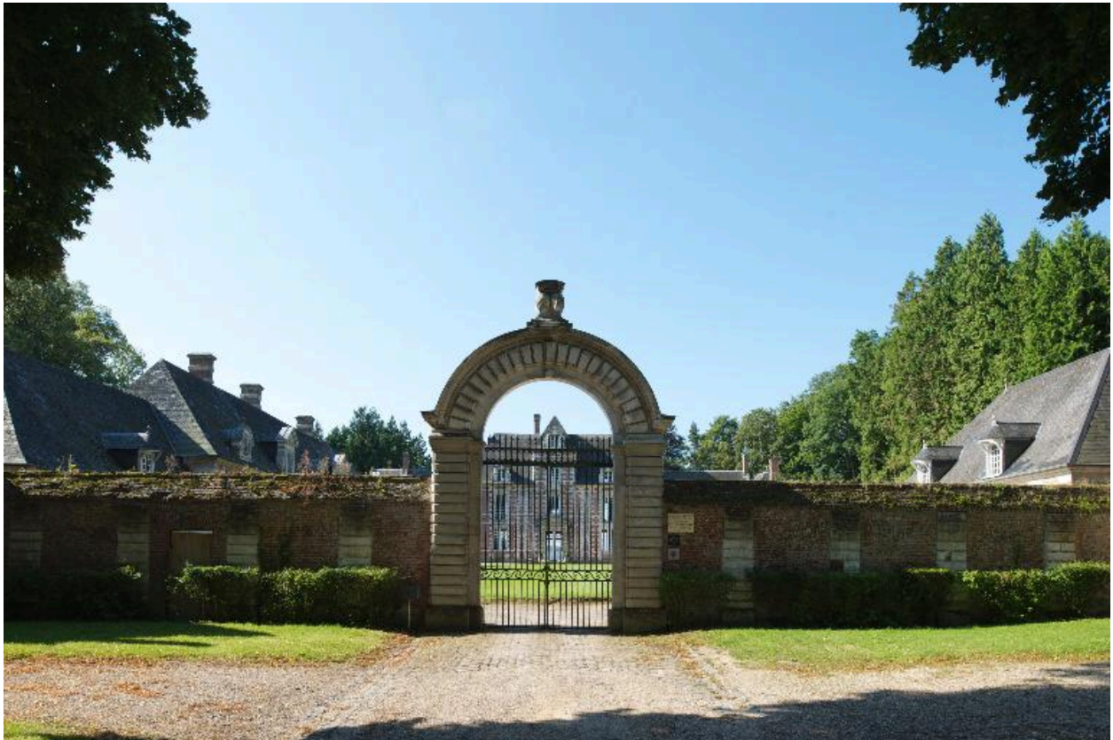
Mur de clôture de la cour et portail principal.
