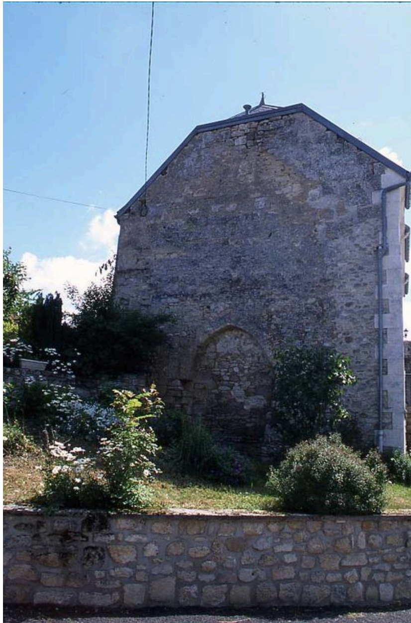
Vue du pignon percé d'un arc brisé aujourd'hui aveugle.
