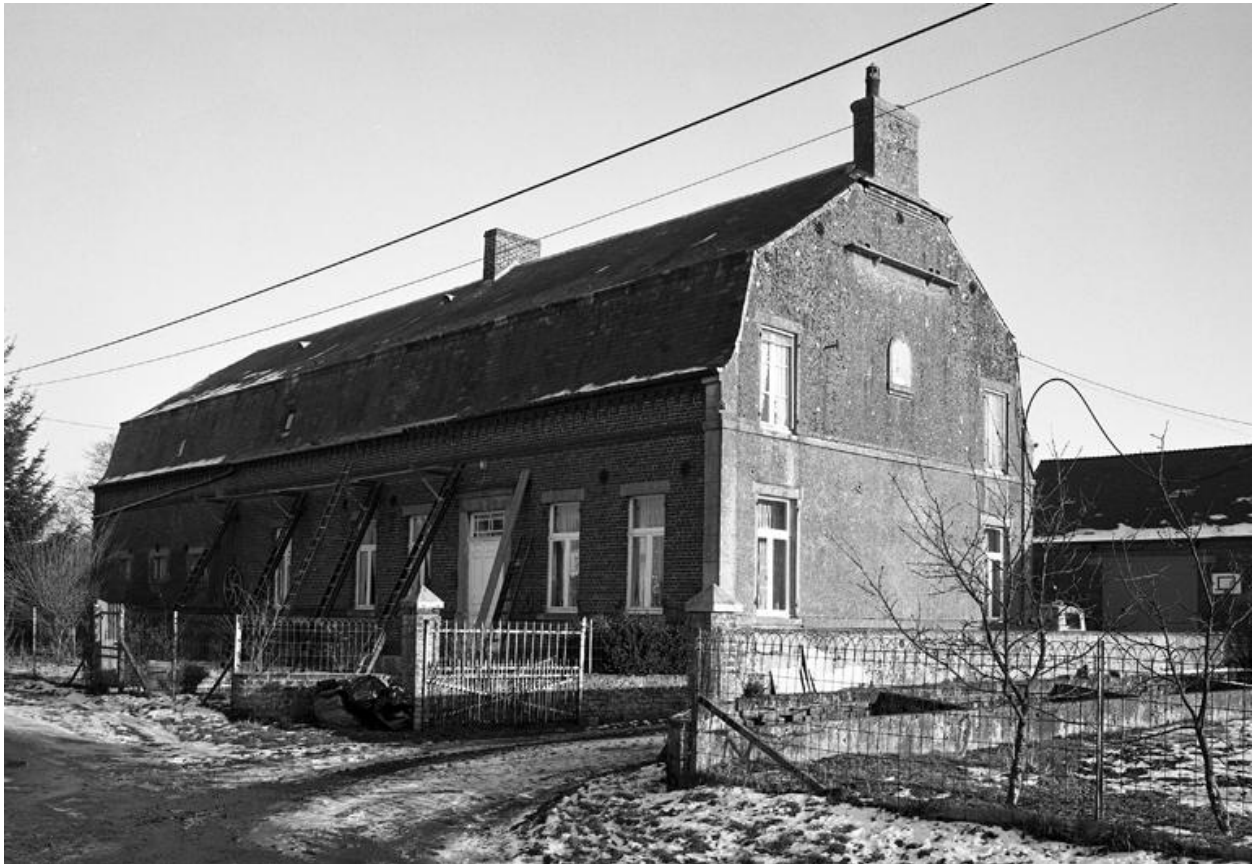
Le logis. Façade postérieure.
