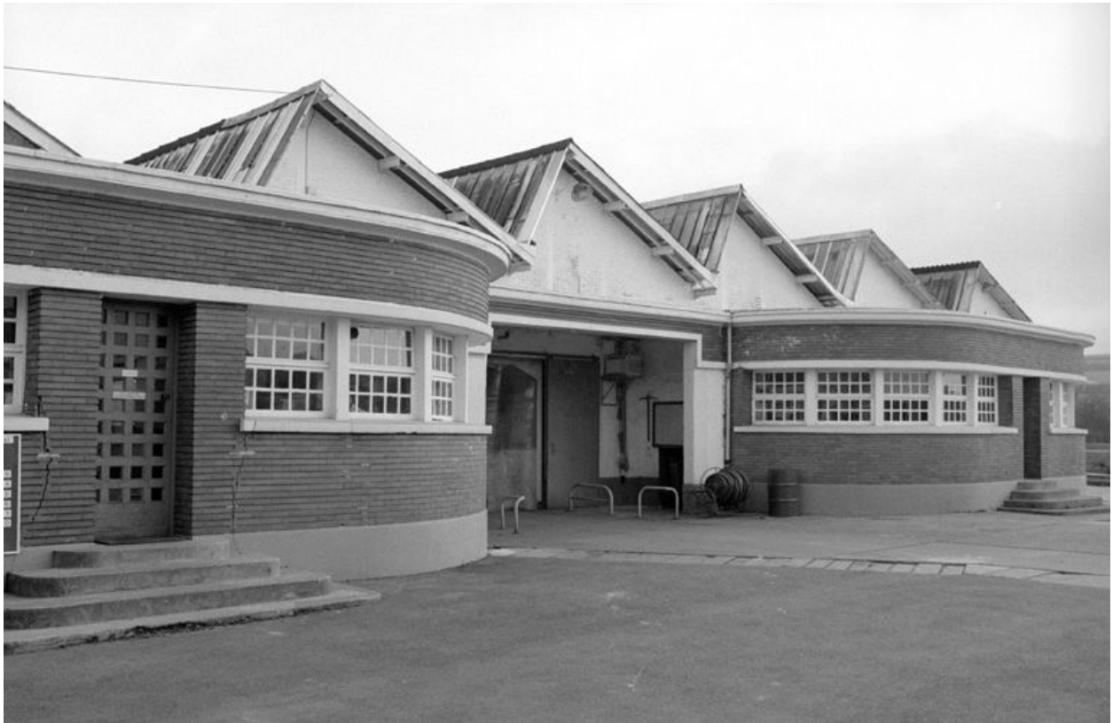
Atelier de fabrication, vue partielle des sheds.
