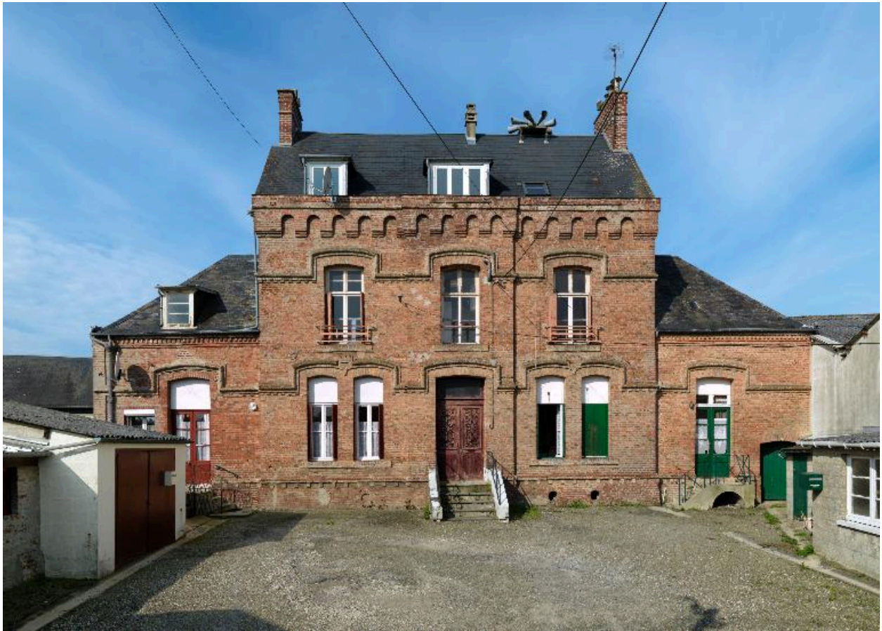
Vue générale depuis la cour.
