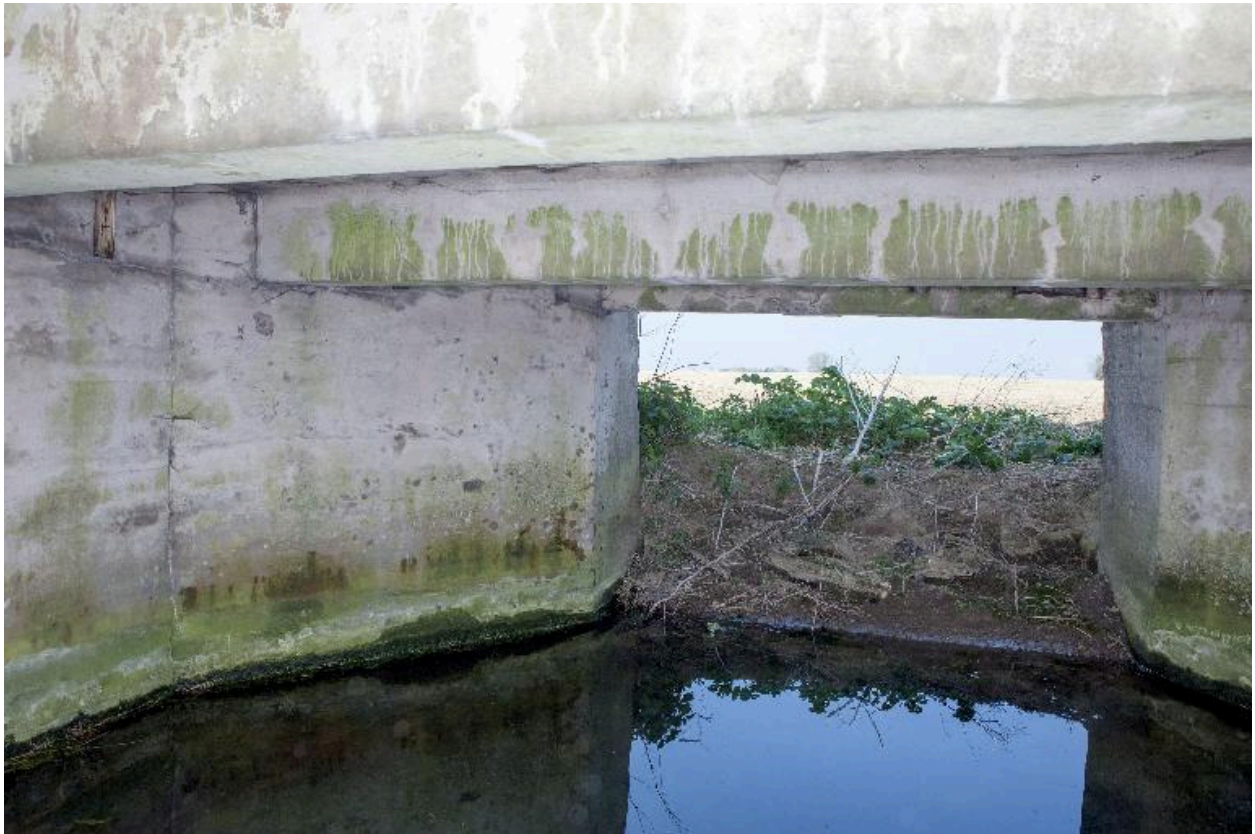
Vue intérieure de la chambre de tir, vers le front
