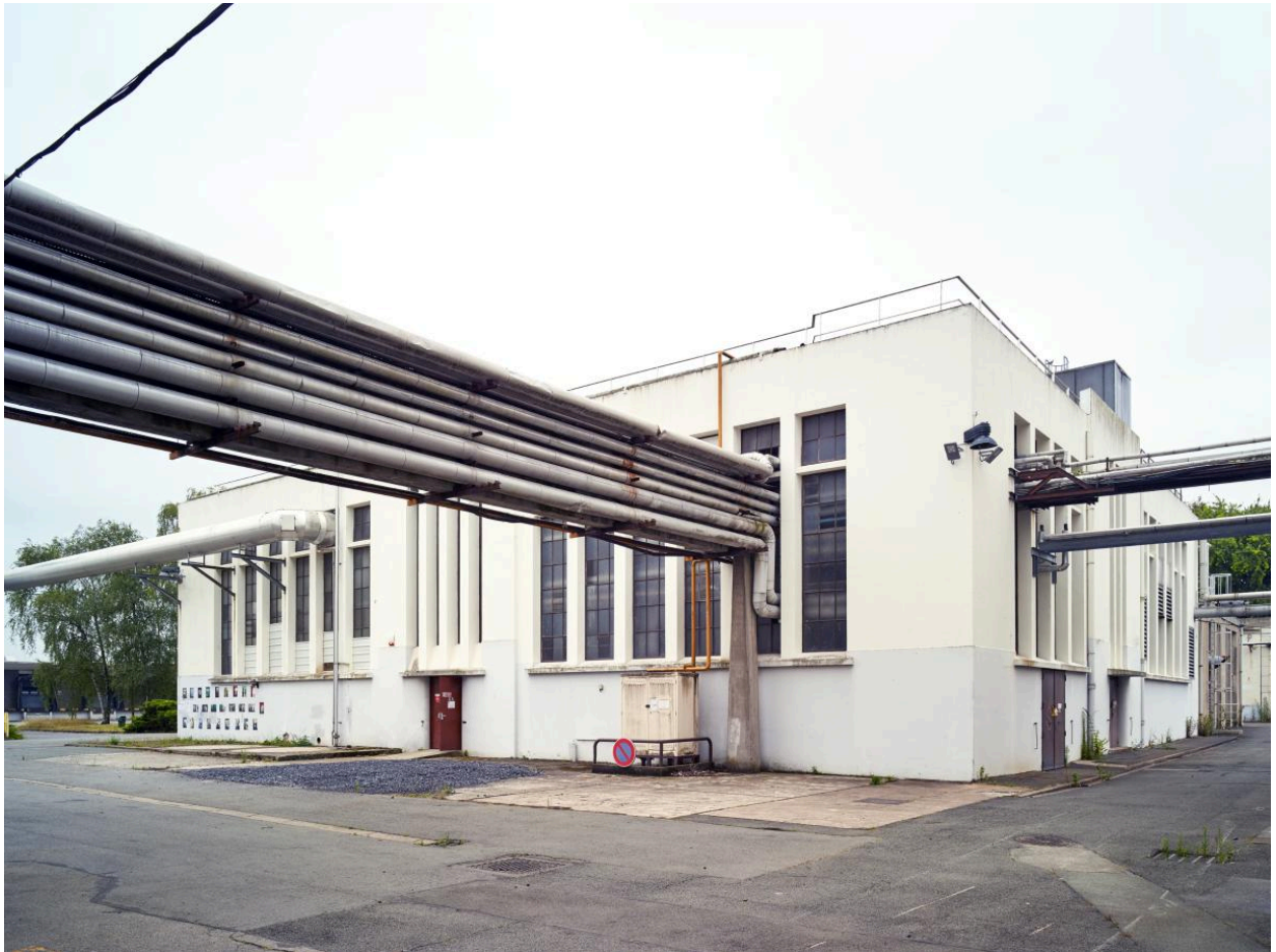
La chaufferie (A) vue de trois-quarts vers le sud-est.
