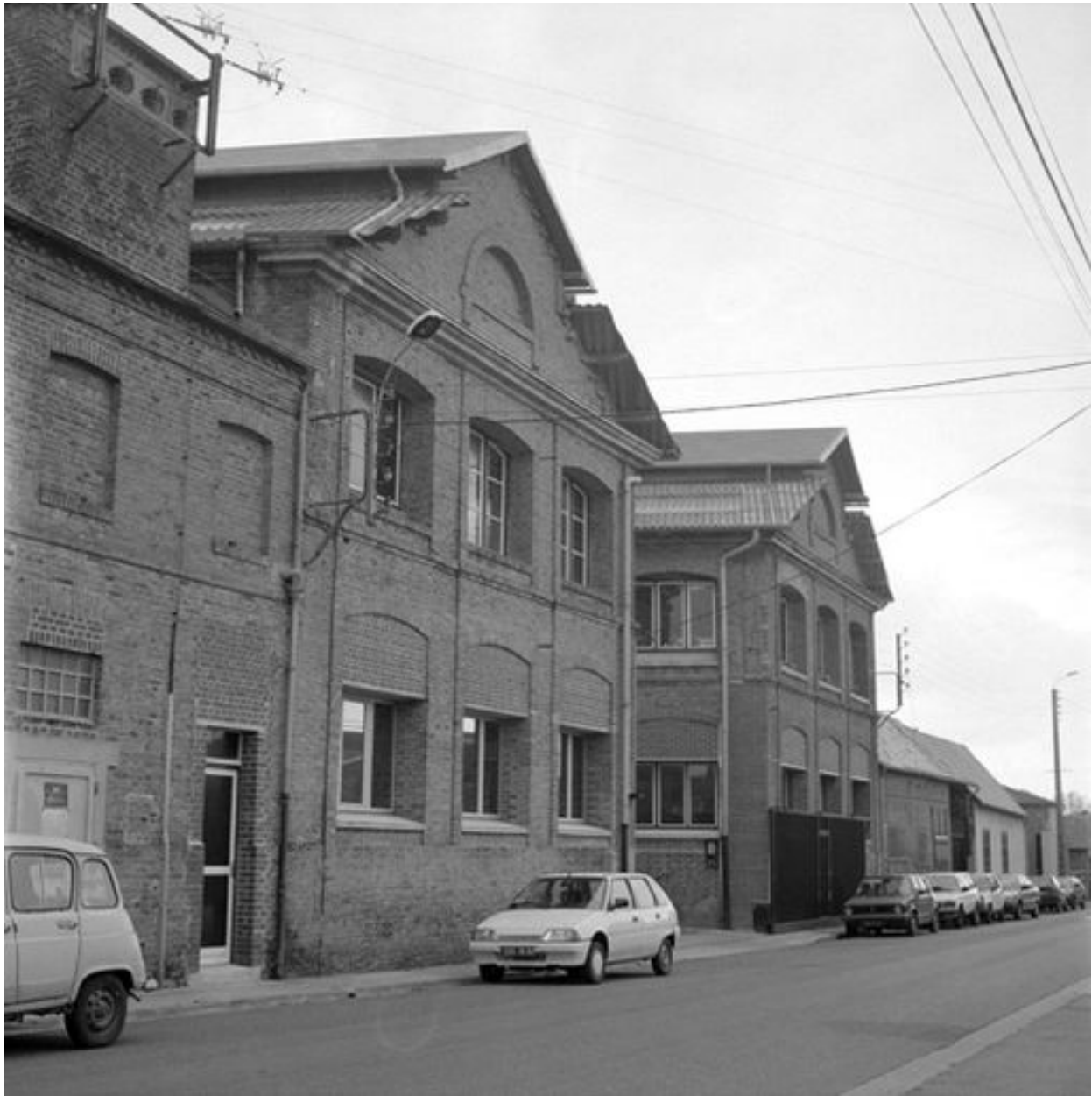
Les anciens ateliers et magasins construits vers 1895, vus depuis la rue Henri-Barbusse, en 1990.
