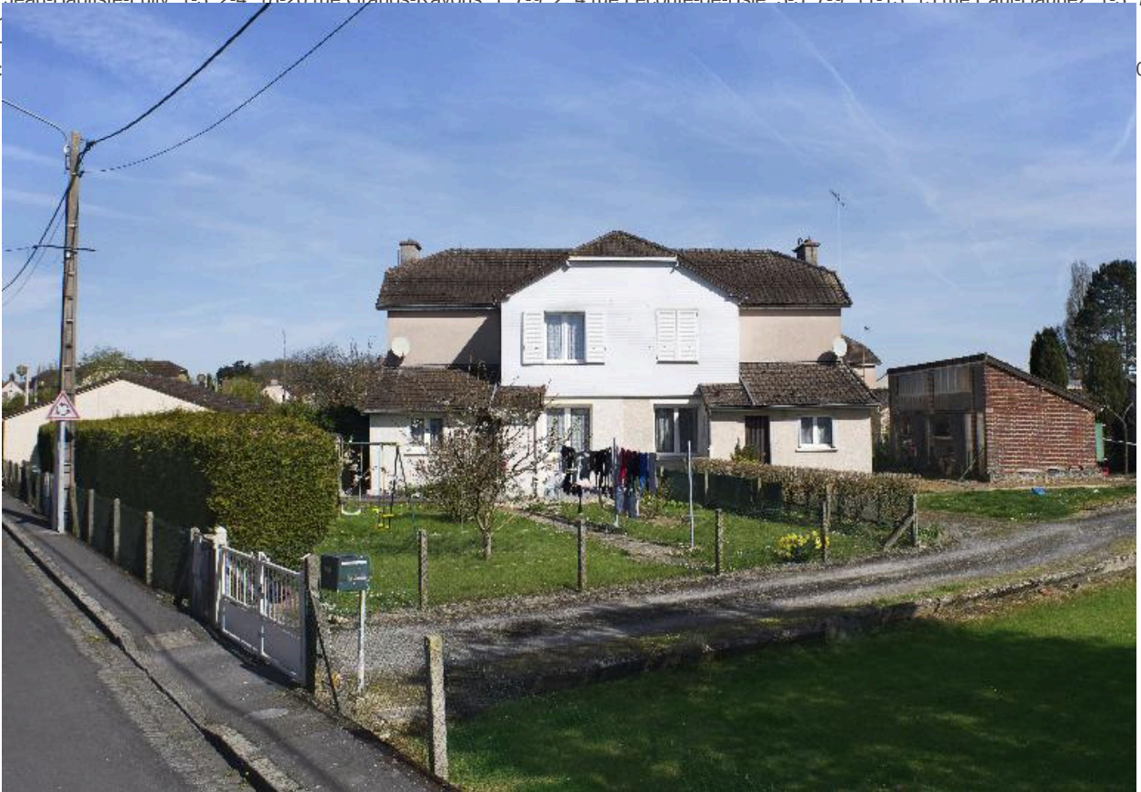
Maison à quatre unités d'habitation (1 et 3, rue de Houdon).
