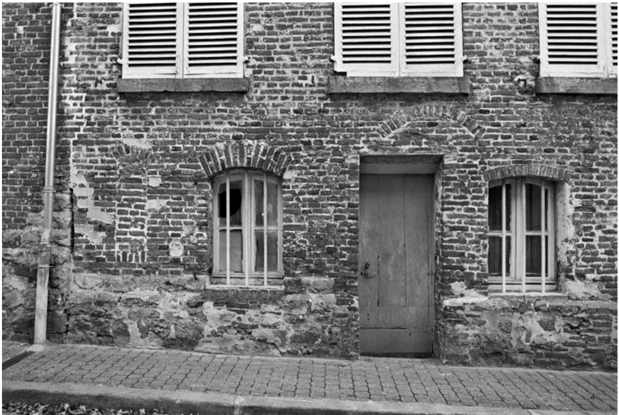
Détail du rez-de-chaussée du logis situé rue Raoul de Coucy.
