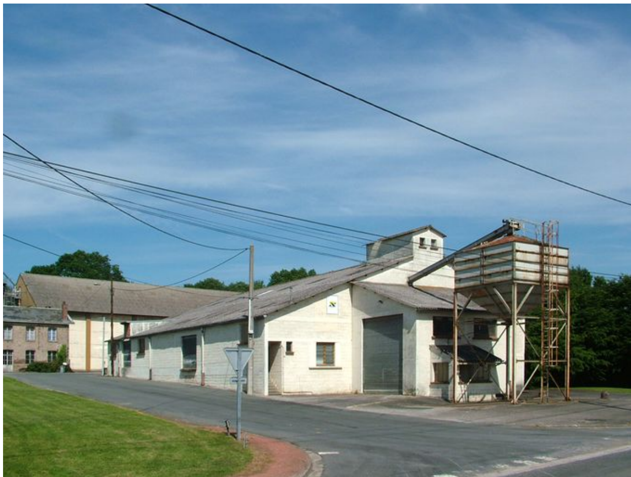
Vue générale du bâtiment administratif sur la rue.
