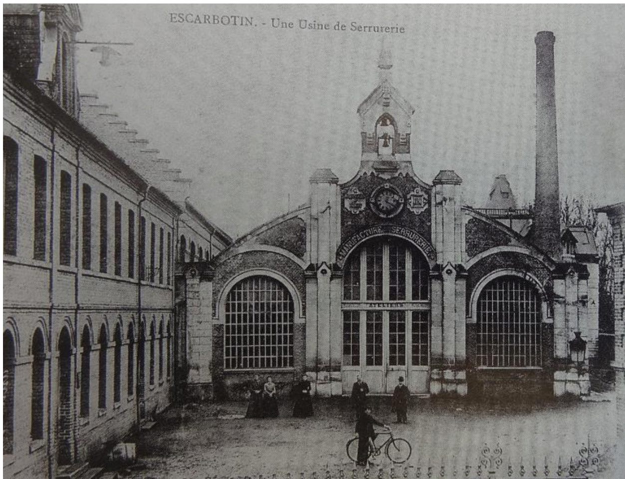
Sortie d'usine, début du 20e siècle (coll. part.).
