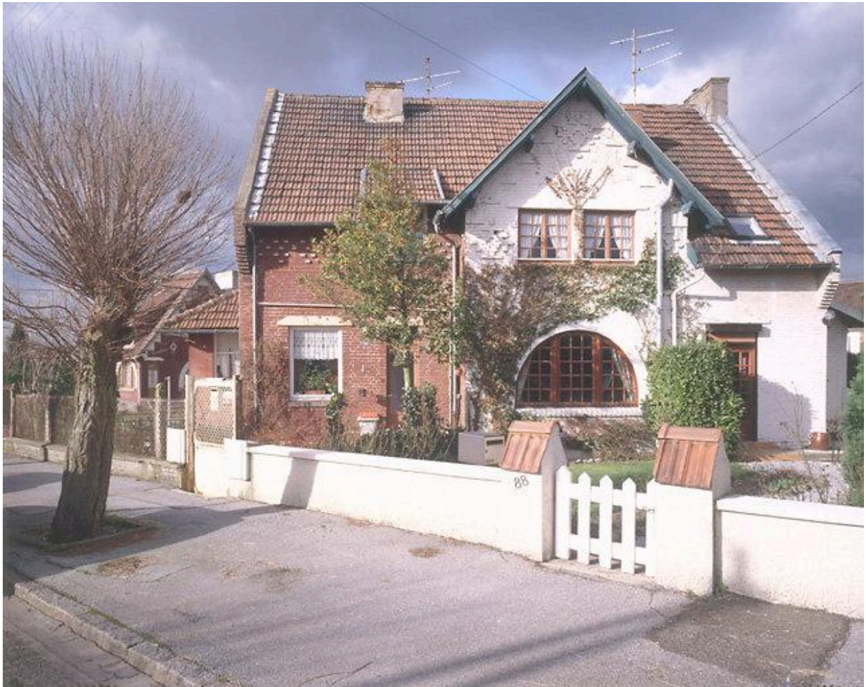
Module d'habitation, maisons jumelées sises aux 88-90 avenue du Général-Leclerc, élévations antérieures.
