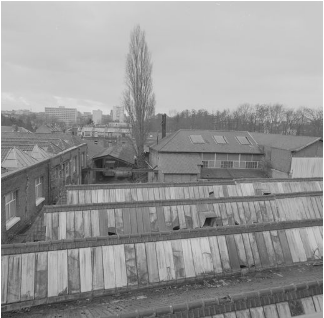
Vue des toitures.
