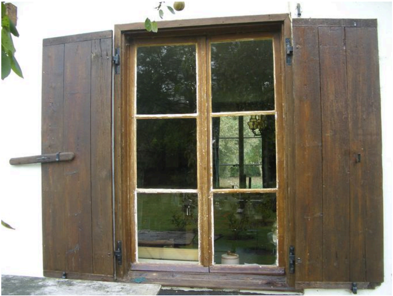
Vue détaillée du système de contrevent à tourniquet.
