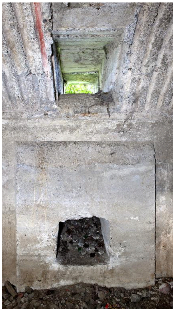
Salle sud niche surmontée d'une baie
