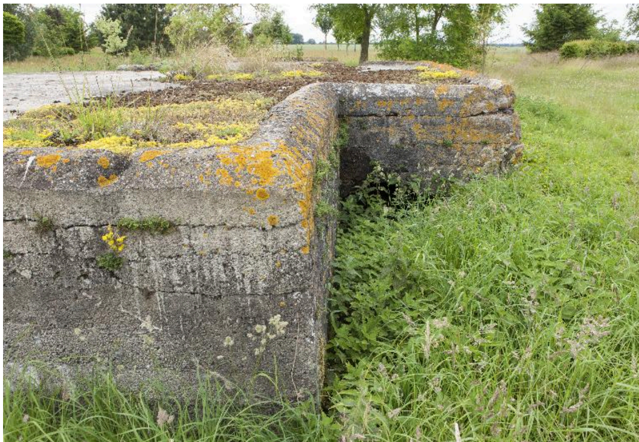
Angle nord-est de la casemate ouest
