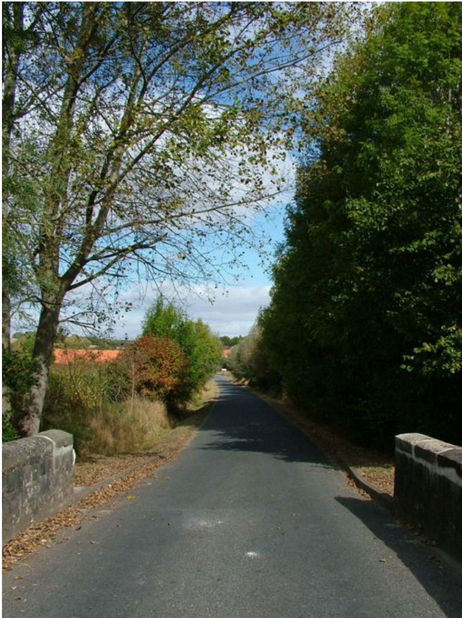
Le pont du Soudet et l'ancienne route de Berteaucourt-les-Dames à Pernois.
