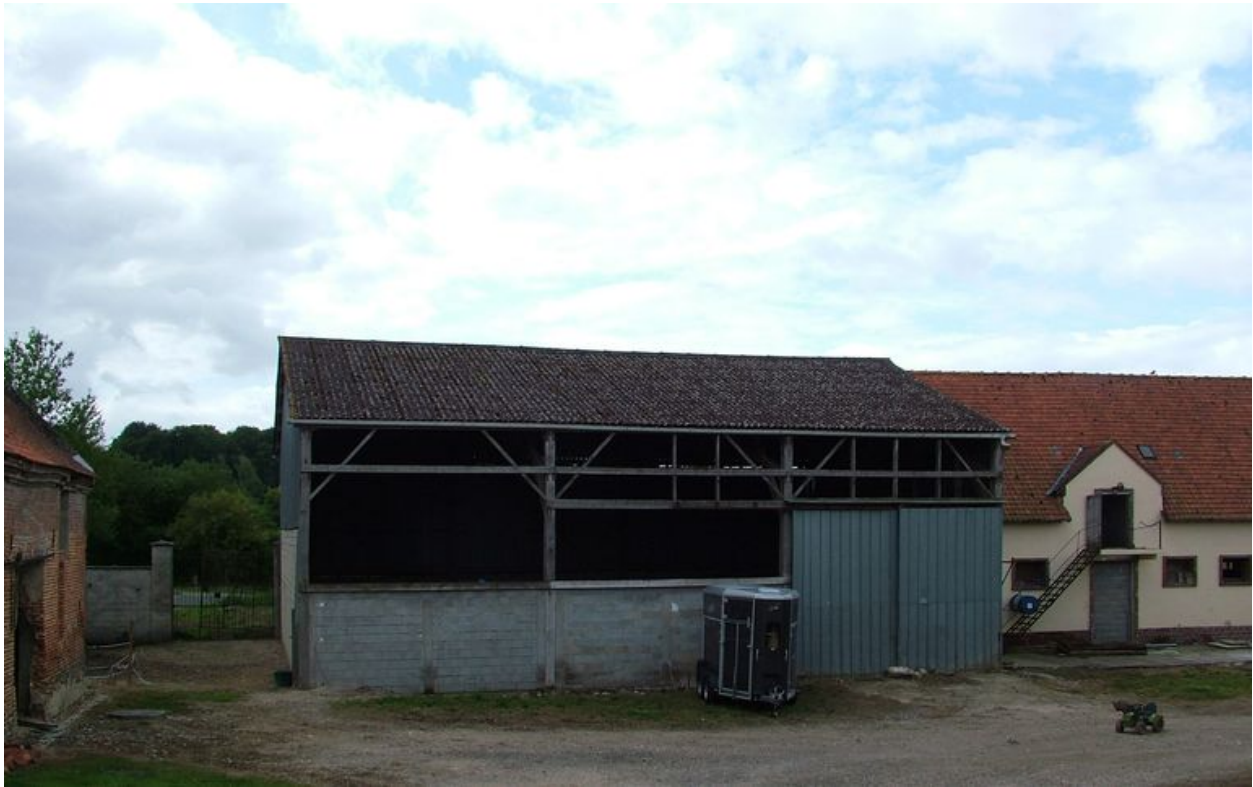
Vue de la grange et de l'écurie modernes sur la cour.
