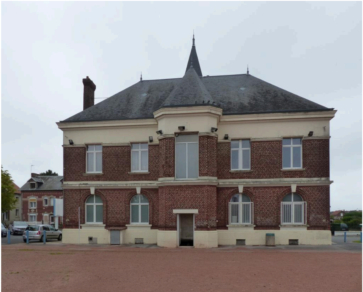
Vue de la façade arrière (ouest).
