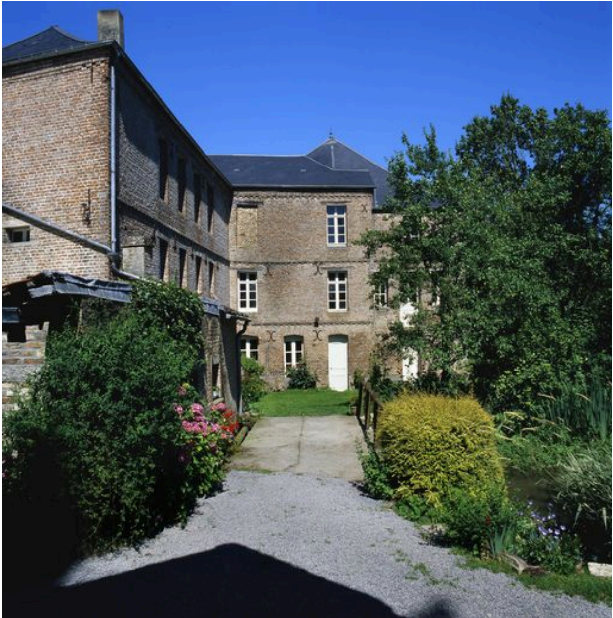
Vue d'ensemble de la façade arrière des bâtiments de la minoterie.
