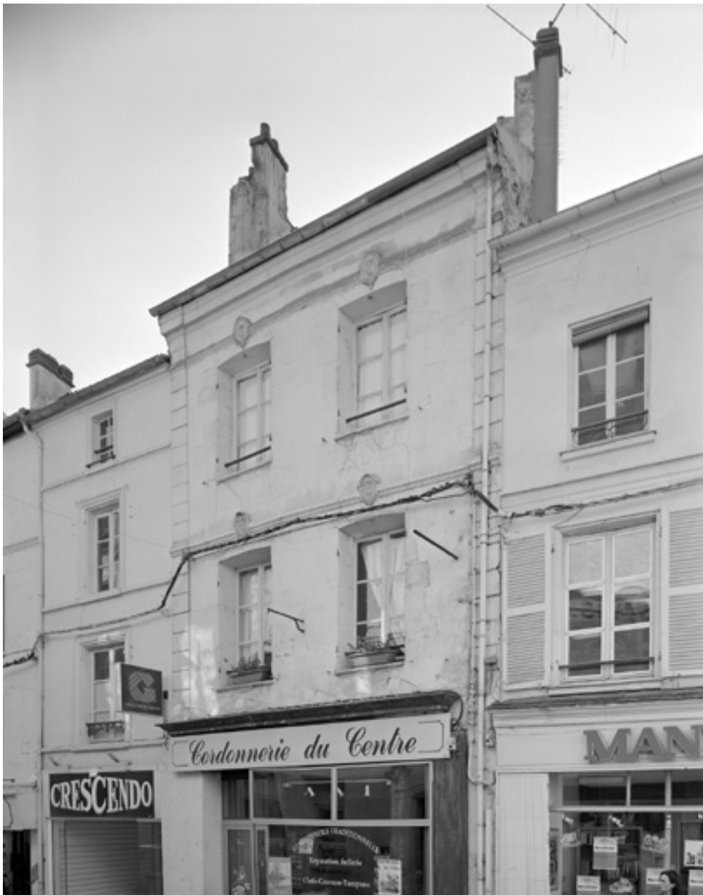
Maison, 68 Grande-rue. Élévation sur la rue.
