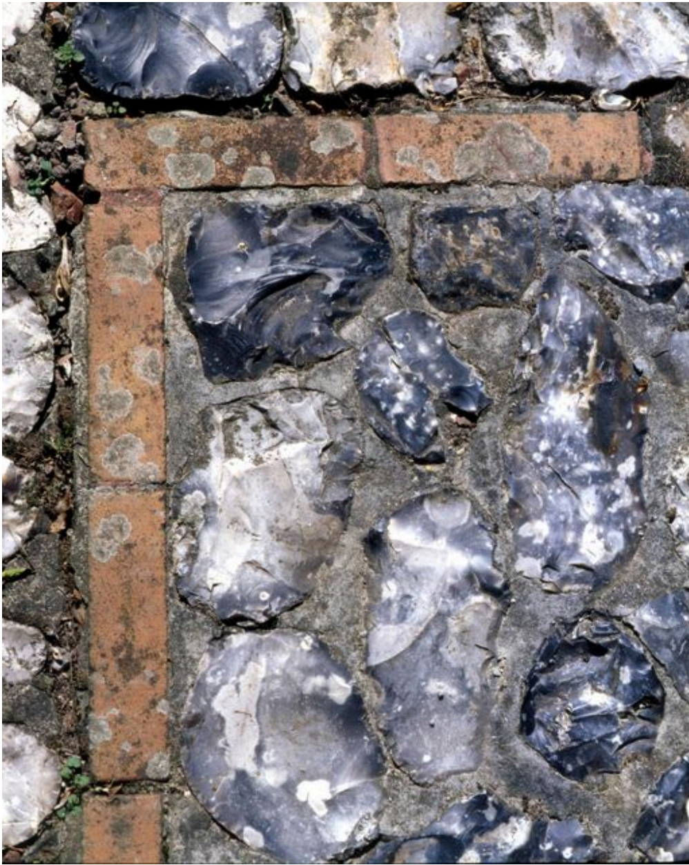
Détail de la mise en oeuvre de l'escalier menant au jardin (rognons de silex).
