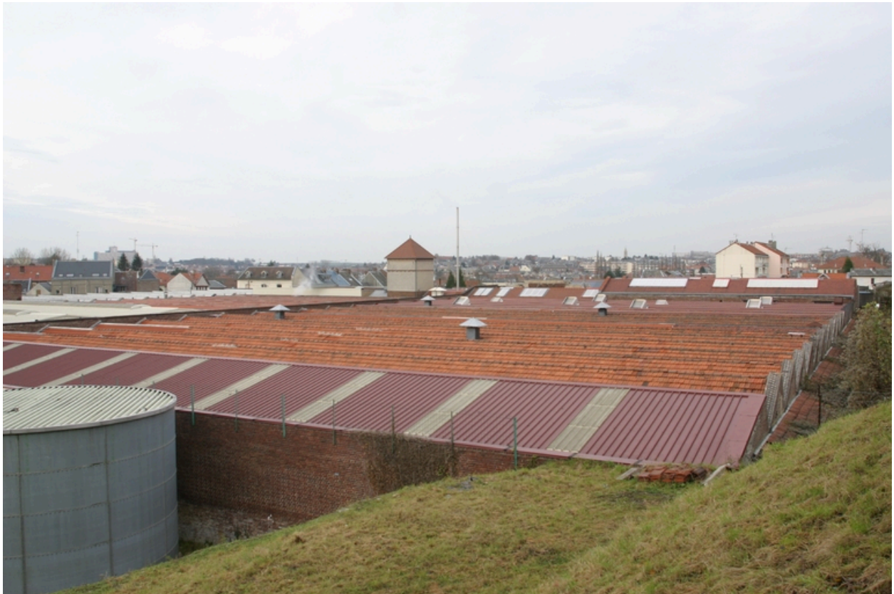
Les ateliers vus du sud-est.
