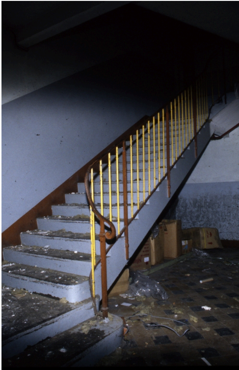
Détail de l'escalier d'accès à l'étage supérieur des ateliers de fabrication de la filature et des bureaux techniques, 2001.
