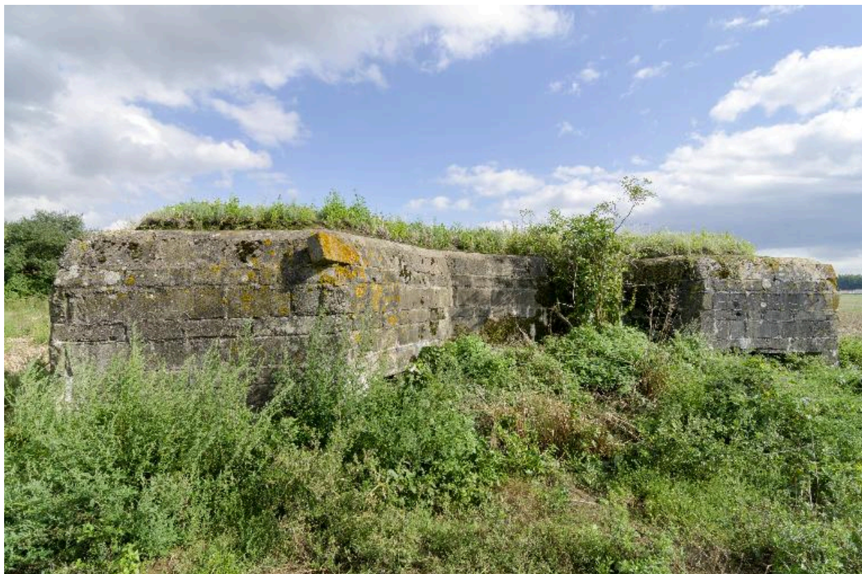
Elévation ouest, vers le sud-est (au grand angulaire)
