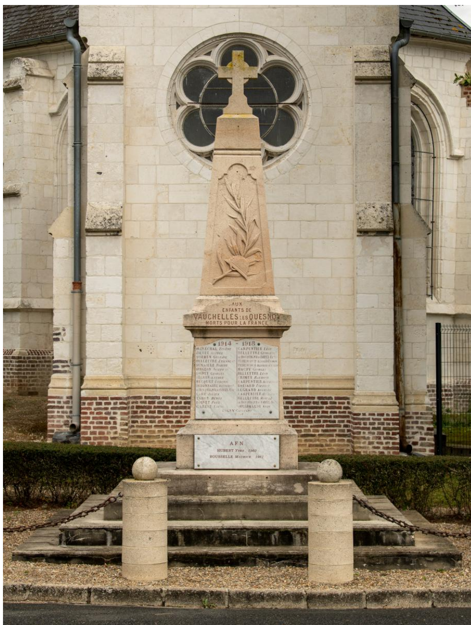
Vue générale depuis le sud
