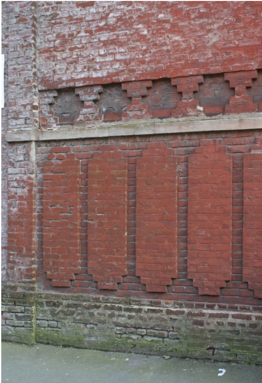
Détail de l'appareillage des briques.
