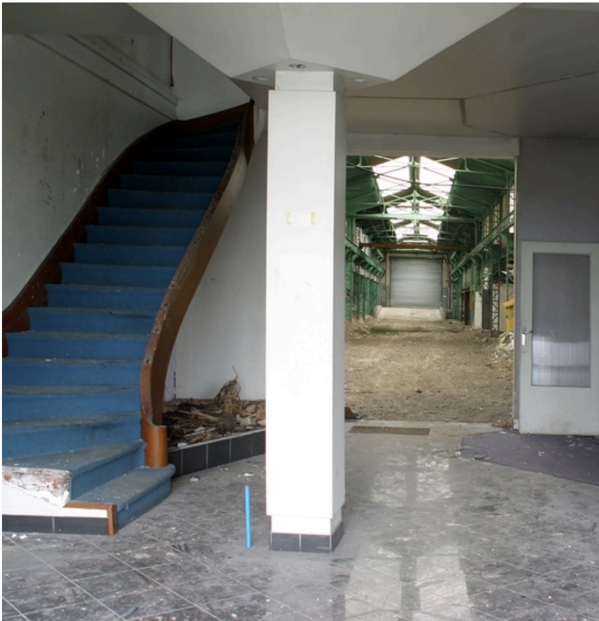
Hall d'entrée des bureaux et des ateliers de 1923, rue Voltaire.
