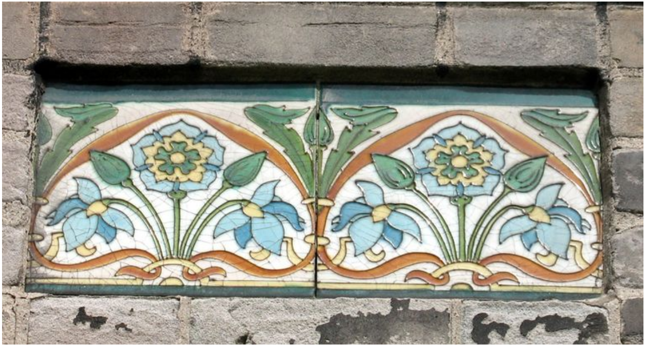
Détail des carreaux de céramique ornant la porte d'entrée.
