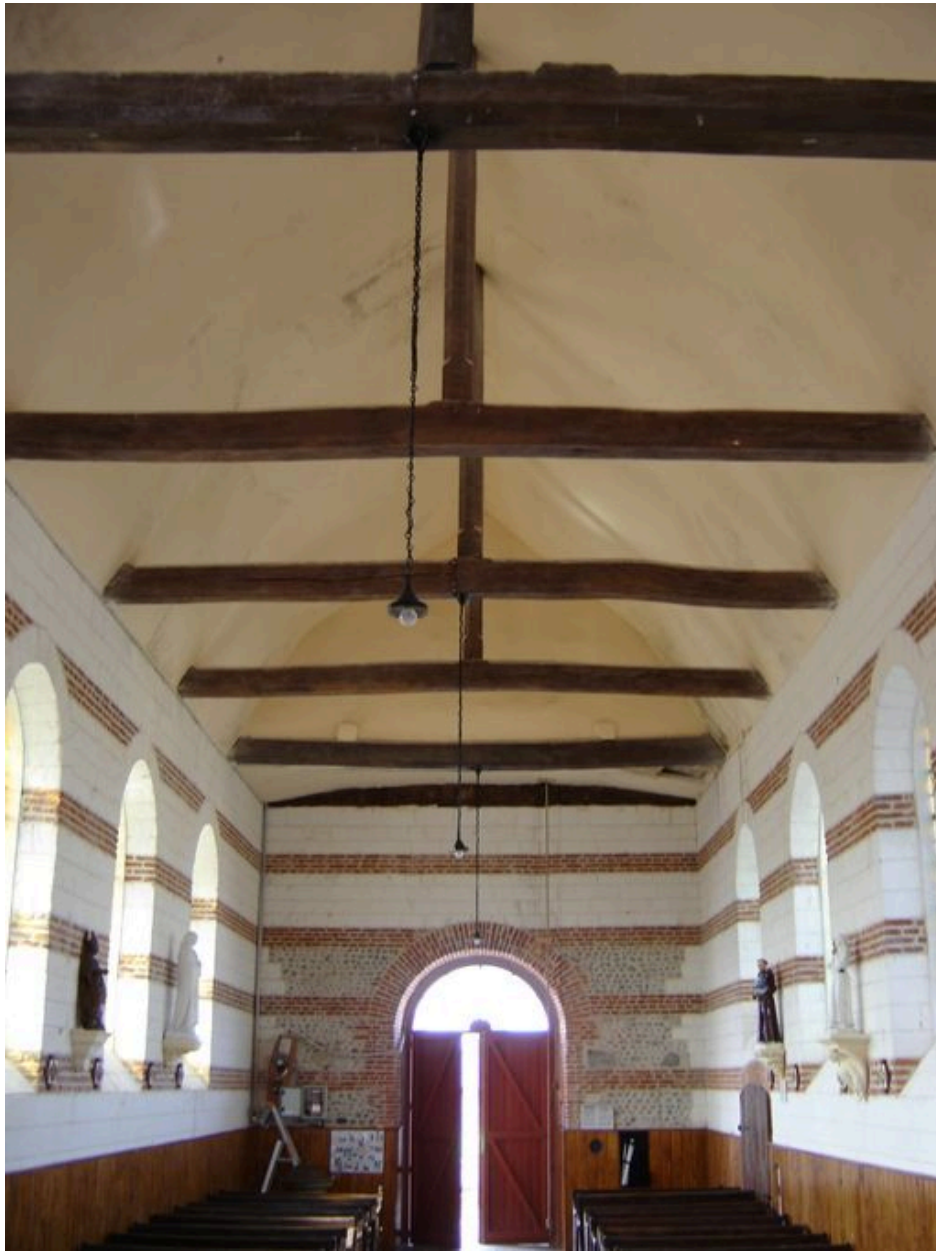
Vue intérieure de la nef.
