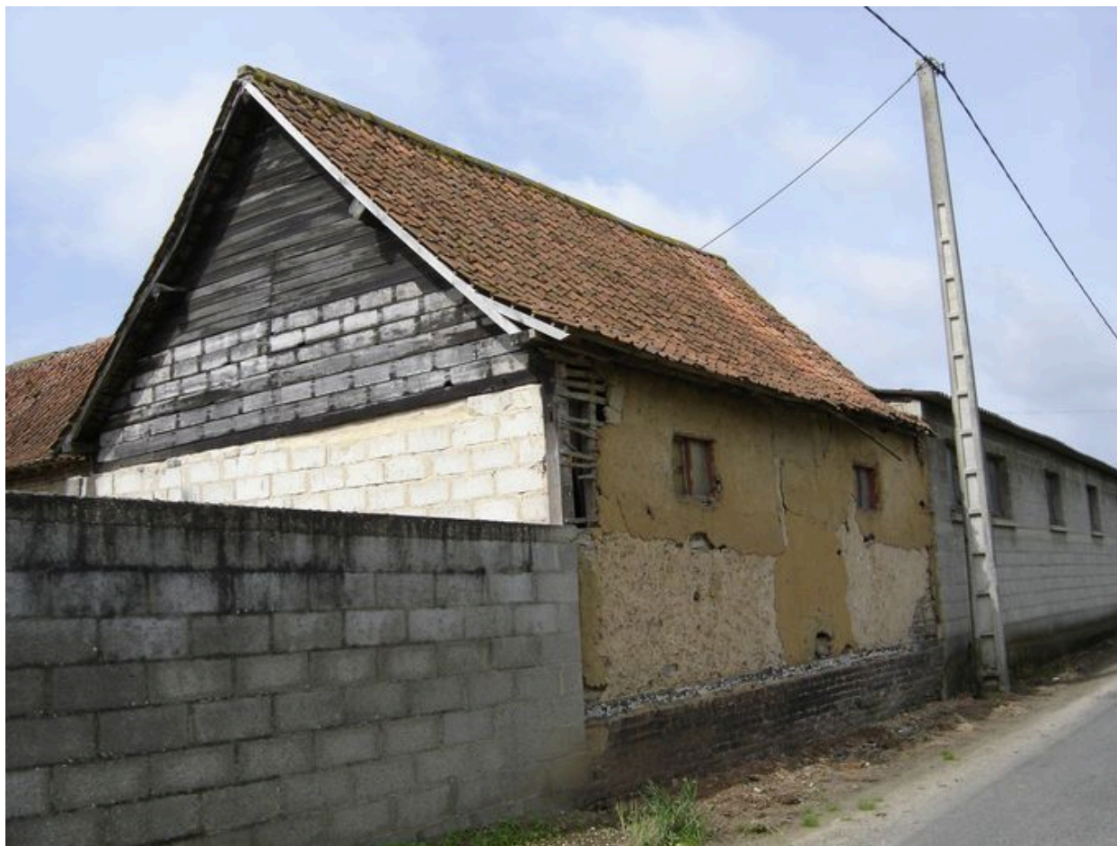
Vue de la grange sur rue.
