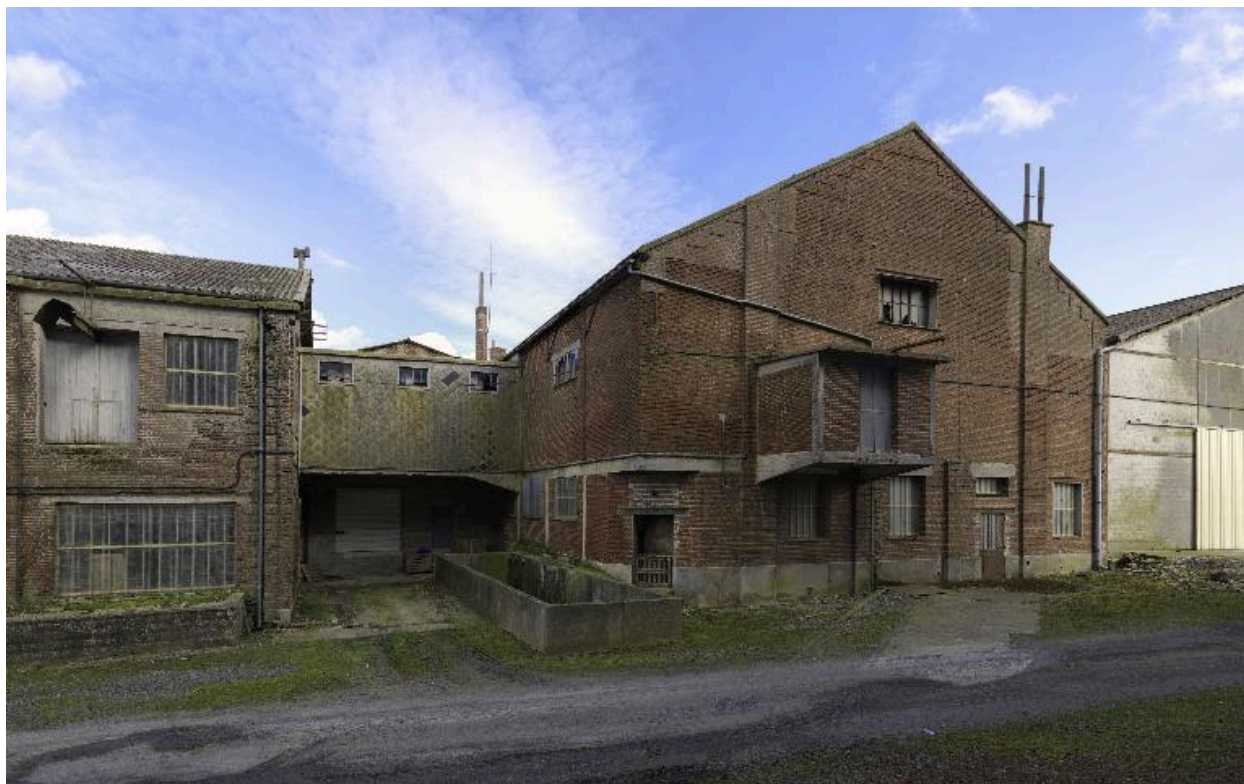
Pignon nord de l'extension de l'atelier de fabrication.
